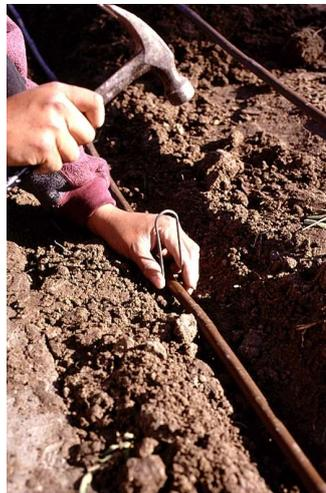
Utilizar grampos ou fixadores metálicos em cada conexão de inserção com pressão acima de 25 mca
